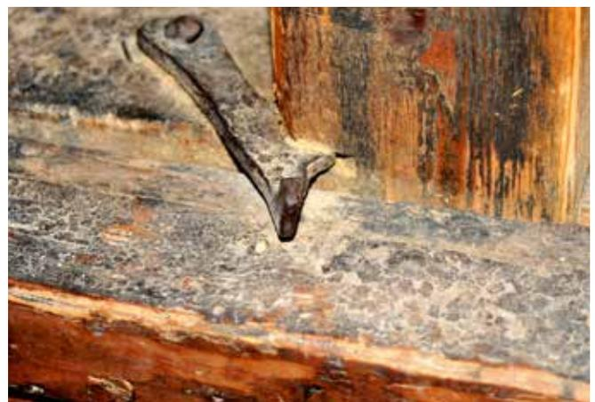
Sperrvorrichtung eines Schießers
